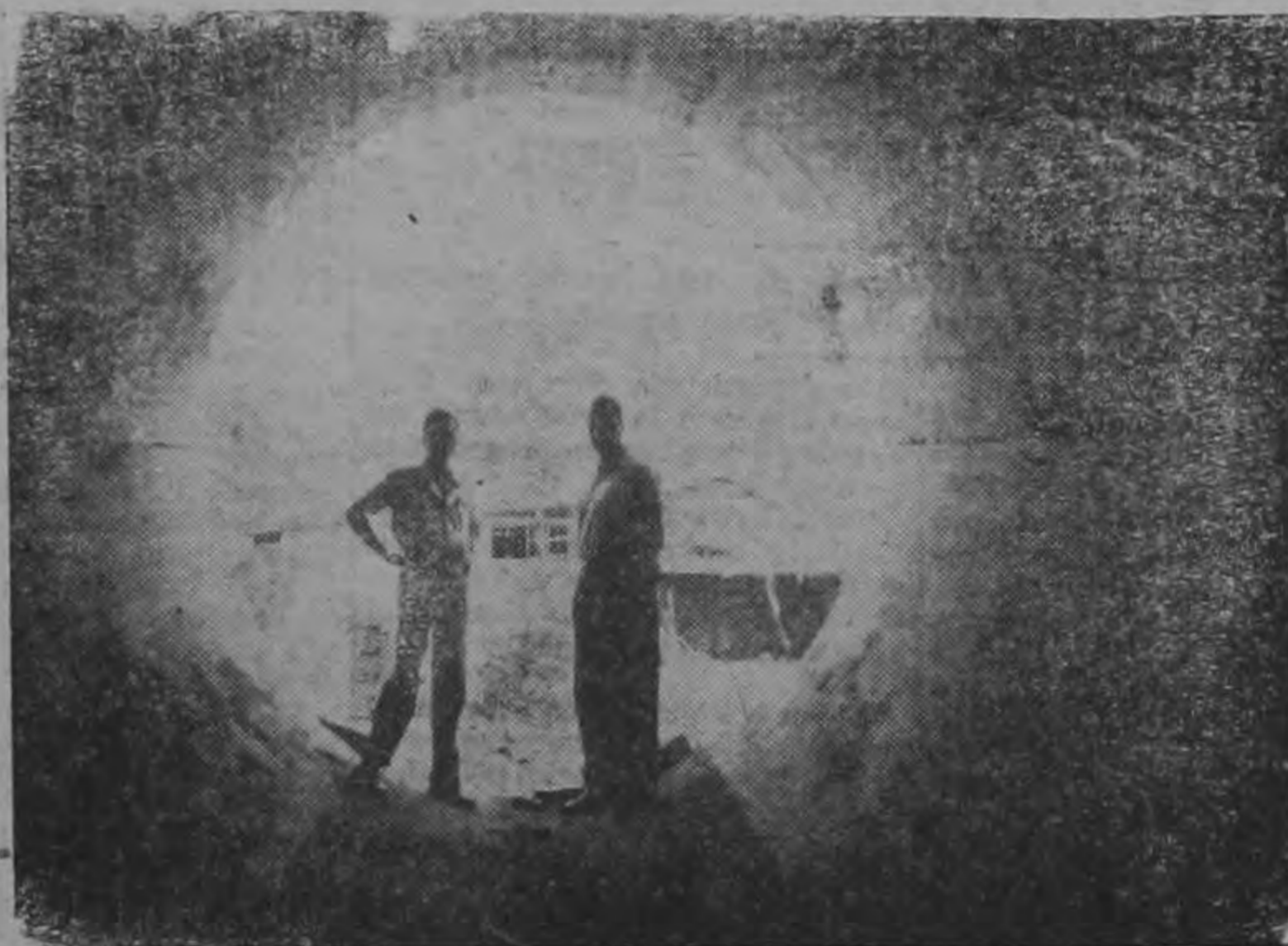
Vista interior del sifón
